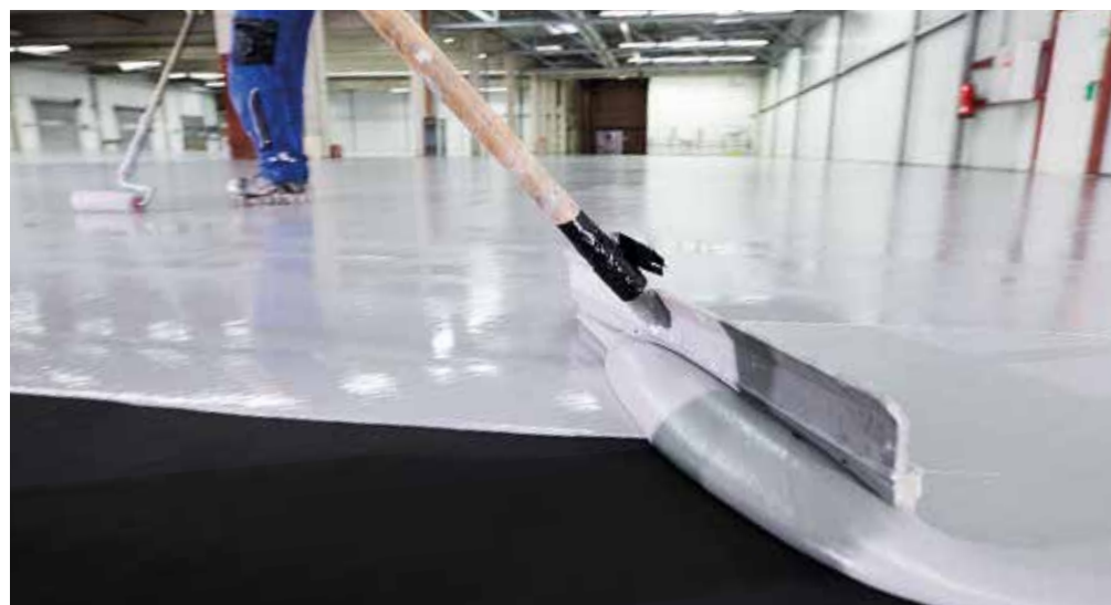
Remmers Epoxy SIC Color ESD wird auf die mit Epoxy Conductive beschichtete Fläche aufgebracht.
