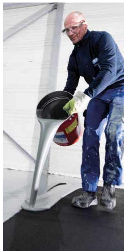
Remmers Epoxy SIC Color ESD wird auf die mit Epoxy Conductive beschichtete Fläche aufgebracht.
