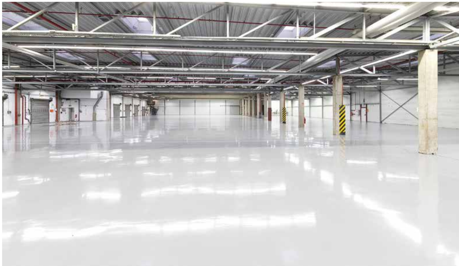
Die ehemalige Logistikhalle in Schieder-Schwalenberg wurde zu einer Produktionshalle mit ESD-gerechter Bodenbeschichtung umgebaut.
